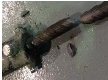
b) Bar tensile failure
